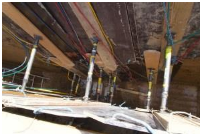
Figura 20. Entibación progresiva. Fuente: www.rescateurbanousar.com
