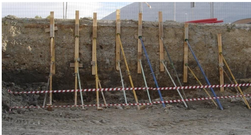
Figura 15. Entibación. Fuente: Fundación Musaat.
